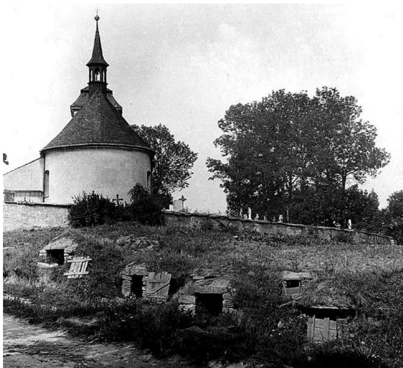
Obrázek 179: „Doly“ v Lou- kově u bystřice pod Hostýnem, zahlabované při živé komunikaci. Na trati Zákos- telí položena na široké výměře pozemku. Zaměřena v roce 1936. Stav v době opuštění techniky, za re- konstrukce novo- staveb rolnických nemovitých zařízení.
